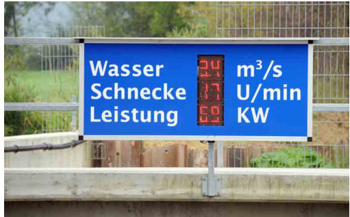
Abb. 2 Anzeigetafel der Pilotanlage in Hirsthal
