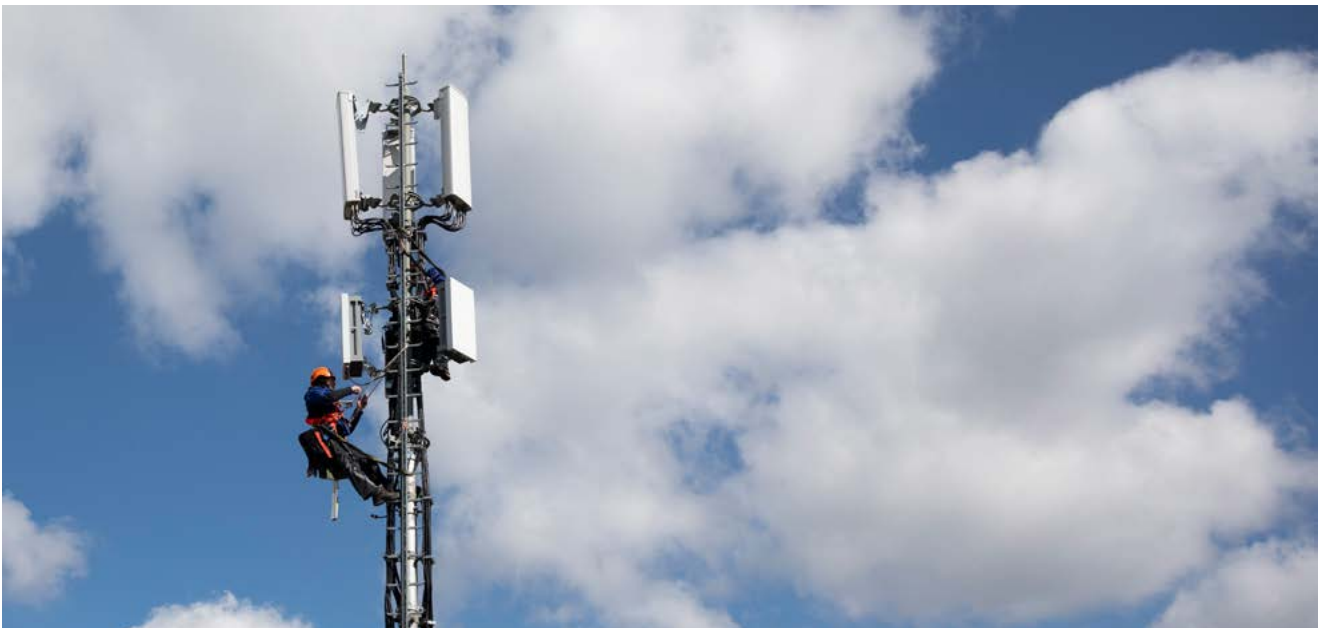
Installation einer 5G-Antenne in Bern
