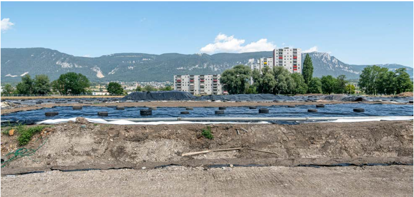
Sanierung der Deponie Stadtmist in Solothurn
