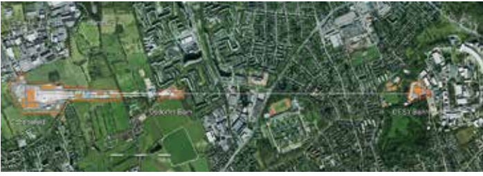
Fig 3: Die 3,4 km lange Röntgenlaseranlage European XFEL verläuft zu einem großen Teil unterirdisch. Die drei Betriebsgelände (rot umgrenzt) liegen in Hamburg (DESY-Bahrenfeld und Osdorfer Born) und im Süden der Stadt Schenefeld (Kreis Pinneberg, Schleswig-Holstein). Luftaufnahmen: FHH, Landesbetrieb Geoinf. und Vermessung. ©: European XFEL
