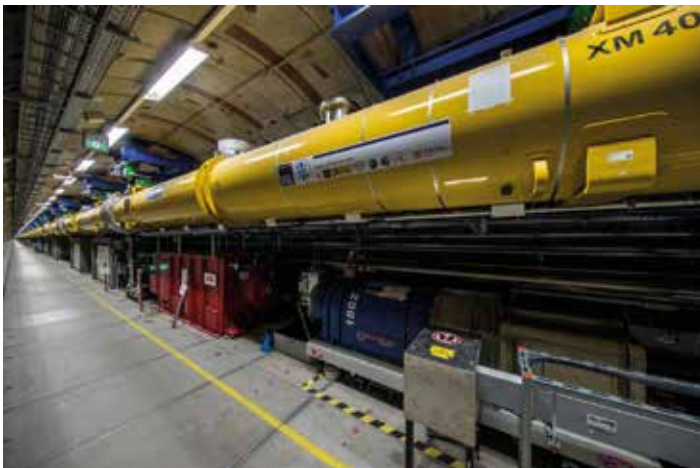
Fig. 1: Blick in den 2,1 Kilometer langen Beschleunigertunnel des European XFEL mit den gelben supraleitenden Beschleunigermodulen. ©: DESY 2017
