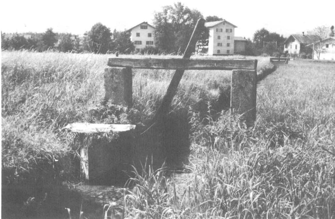
Abb. 39 Schleusenanlage im Steinachergraben. Verfallene Britschen werden heute oft nicht mehr ersetzt – Symbol der abnehmenden Bedeutung der Wässermatten für die Landwirtschaft.
