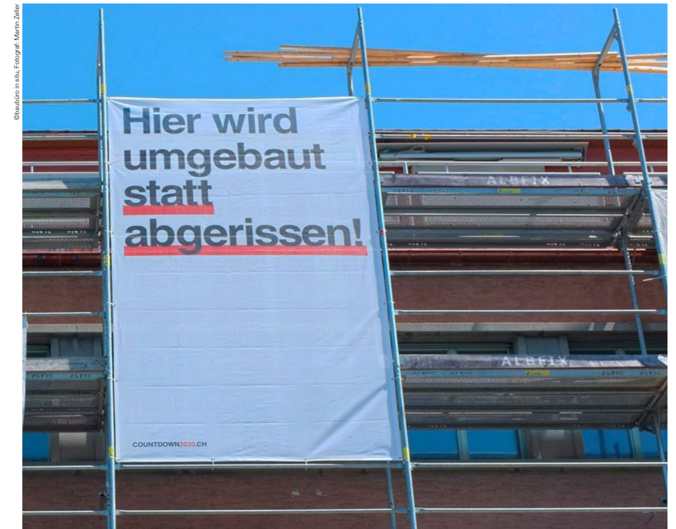
Kopfbau Halle 118, Winterthur CH
