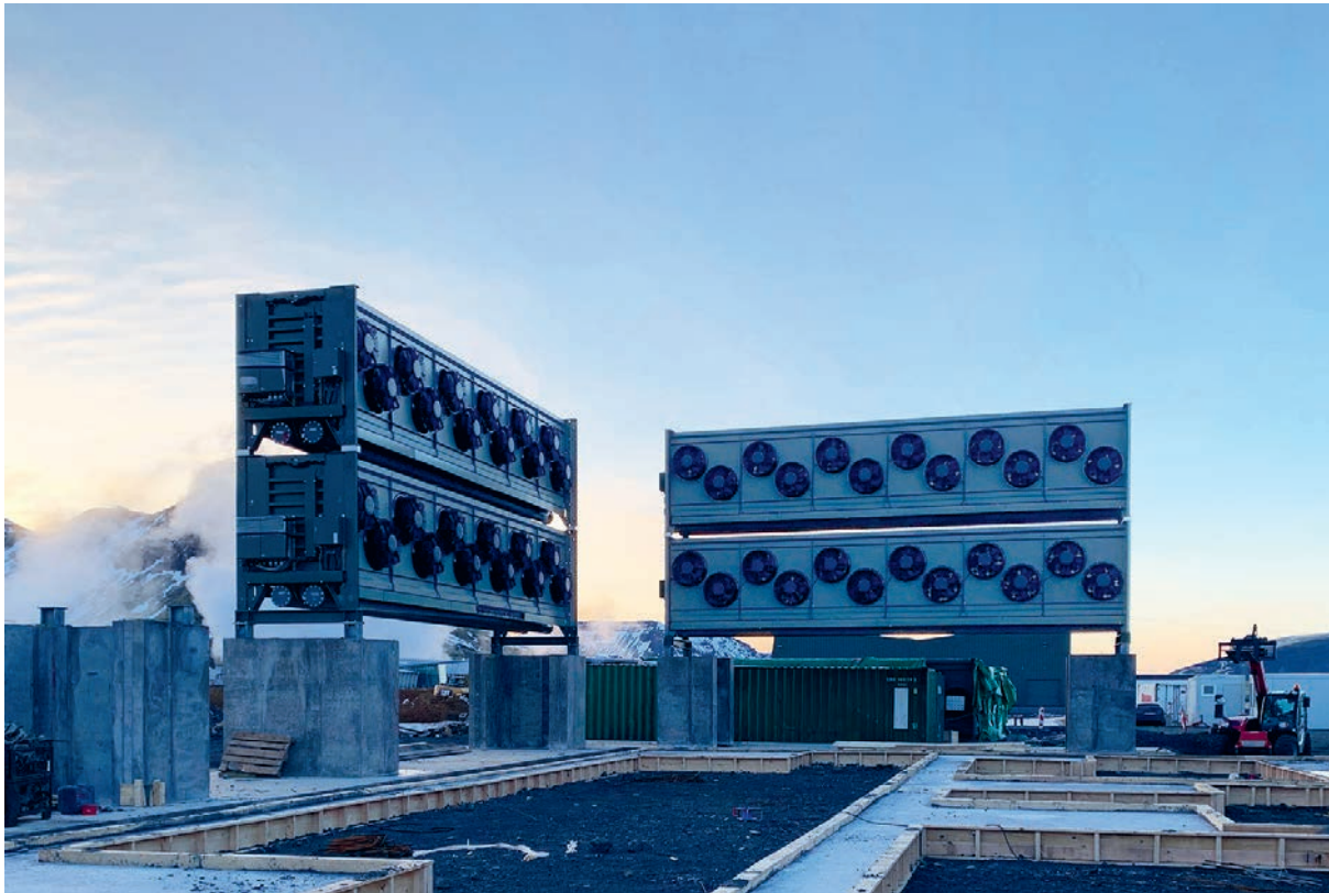
Neue Technologien wie CDR können CO 2 direkt aus der Atmosphäre entfernen. Die «Orca plant» in Island des Unternehmens «Climeworks» entfernt CO 2 direkt aus der Luft, dieses wird danach verflüssigt und im Untergrund eingelagert. Auch wenn das Potenzial solcher Verfahren gross ist, stehen sie vor zahlreichen Herausforderungen. Zugleich liegt ein Moral-Hazard-Problem vor. Der Artikel beleuchtet drei mögliche Argumente, weshalb Moral Hazard bei CDR Anlass zur Sorge geben könnte. Foto: Climeworks
