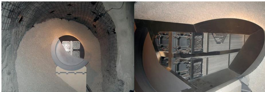
Abb. 2: Ein Stahlkanister enthält in seinem Inneren mehrere Röhren gefüllt mit Uranoxid-Pellets. Der Kanister wird mit Bentonit ummantelt und so in einen Stollen des Opalinustons geschoben, um anschliessend verschlossen zu werden. Im Laufe der Lagerung korrodiert der Stahlkanister weg und die Radionuklide durchqueren die Bentonit- und Opalinustonschicht während mehreren hunderttausend Jahren. Eine Million Jahre nach Einschluss beträgt die Restaktivität noch 0.003%
