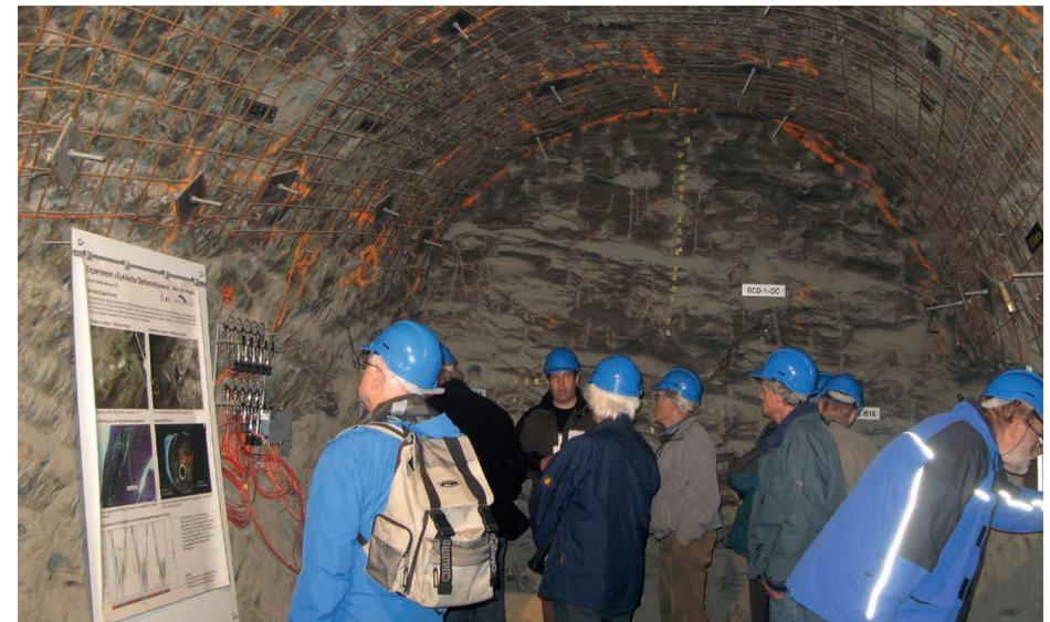
Abb. 1: Die Exkursionsgruppe in einer Exkavation, welche zur Untersuchung des Verhaltens von Opalinuston bei Feuchtigkeit und Trockenheit gemacht wurde. Ebenfalls kann man hier eindrücklich die Selbstabdichtung von Rissen beobachten.
