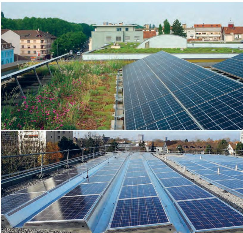
Oben: Photovoltaikanlage Breitezentrum in Basel: vollflächig kombiniert mit einer Dachbegrünung. Foto Stephan Brenneisen. Unten: Kein Platz für «grün»: kostenminimierte Solaranlage. Foto: AUE Basel
