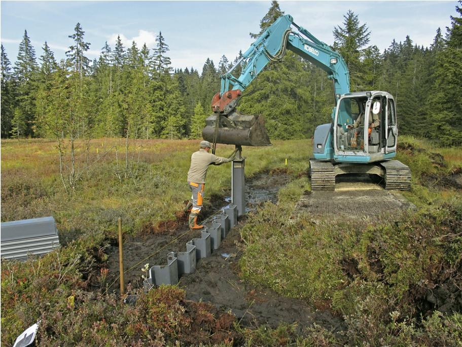
Abbildung 12: Einbau der Spundwände aus Hart-PVC. (Foto: Thomas Leu)
