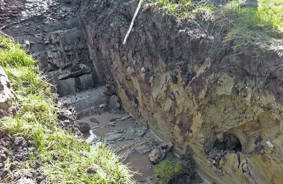
Figure 19: Sondage à la pelle mécanique. (Photo: Olivier Bessire)
