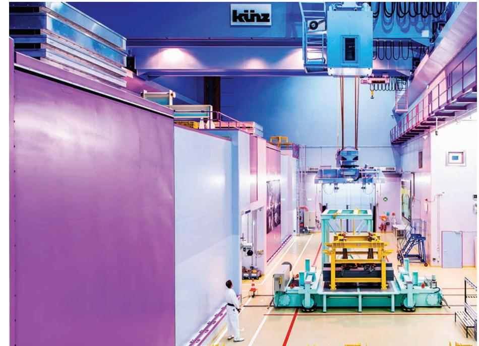
Abbildung 2: Blick in das Empfangsgebäude. Radioaktive Materialien können hier mittels Lastwagen herangeführt und über ferngesteuerte Prozesse entladen sowie weitergeführt werden.
