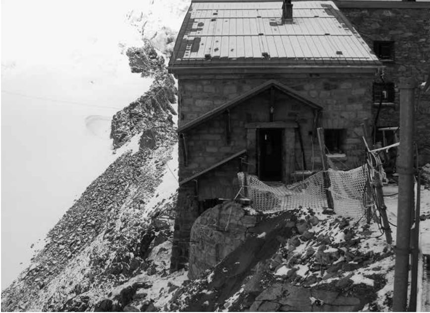
Am Abhang: Cabane des Vignettes CAS. SAC-Hütte im Permafrost während des Umbaus 2007. (Bild: SLF)
