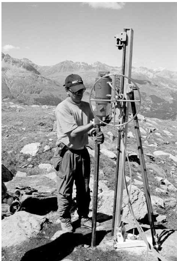
Bohrung im Permafrost im Gebiet Murtèl-Corvatsch Forage dans le permafrost dans la région Murtèl-Corvatsch (Bild/Photo: Susanne Hanson)
