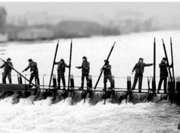
(oben) Hochwasser der Sihl im Zentrum von Zürich: Im Sommer 2005 flossen 280 \text{ m}^3/\text{s} durch die Stadt. (links) Abflussregulierung in früheren Zeiten: Nadelwehr bei Hochwasser. (Bilder: AWEL)
