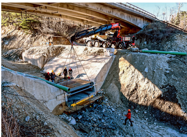
Abb. 2: Links: Der Illgraben mit dem Meretschhorn im Hintergrund (Bild: Christoph Schwörer). Rechts: Einbau der Murgangwaage im Illgraben (Bild: Brian McArdell, WSL).
