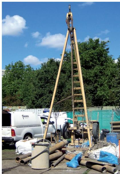
Im Londoner Hyde Park: Glasfasersensoren im Bohrloch überwachen beim Bau einer neuen U-Bahnrohre die bestehende Röhre. (Fotos: Marmota Engineering AG)
