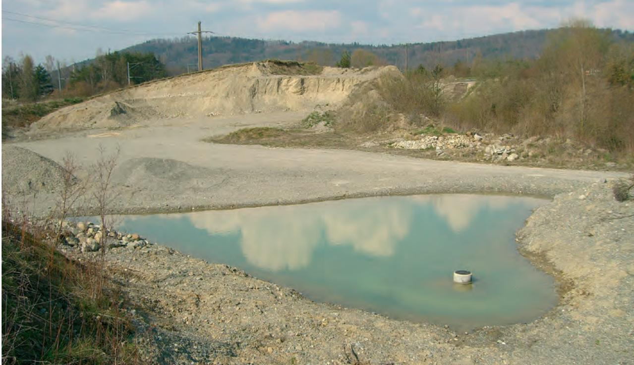
Ein neu erstellter ablassbarer Weiher in einer Kiesgrube im Kanton Zürich. Der Stöpsel vorne rechts dient der Regulierung des Wasserstands. Foto Mario Lippuner
