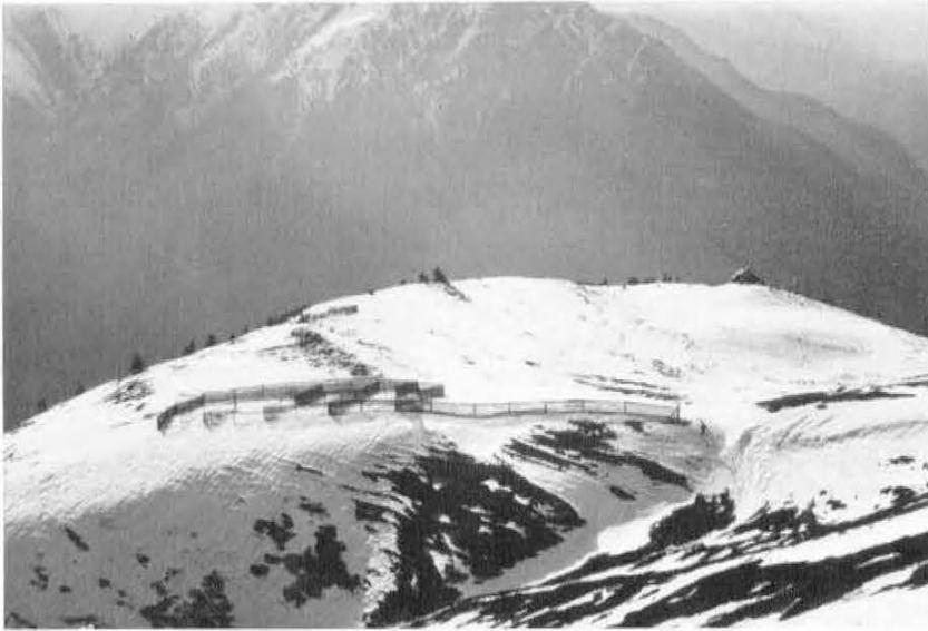
Photo 2. Versuchsfeld auf Saflisch mit Gitteranlagen gegen Gwächtenbildung.
