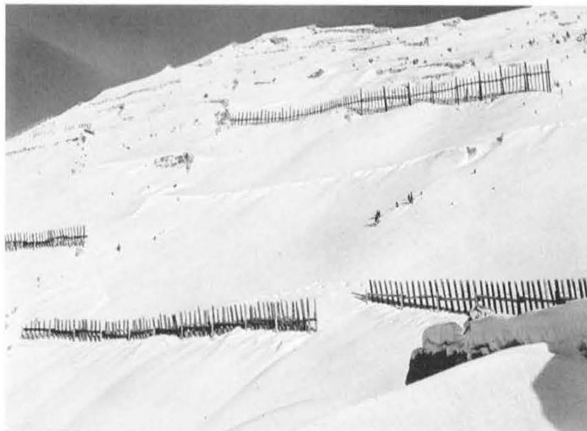
Photo 13. Schneerechen den Mauern aufgesetzt, werden spät eingeweht
