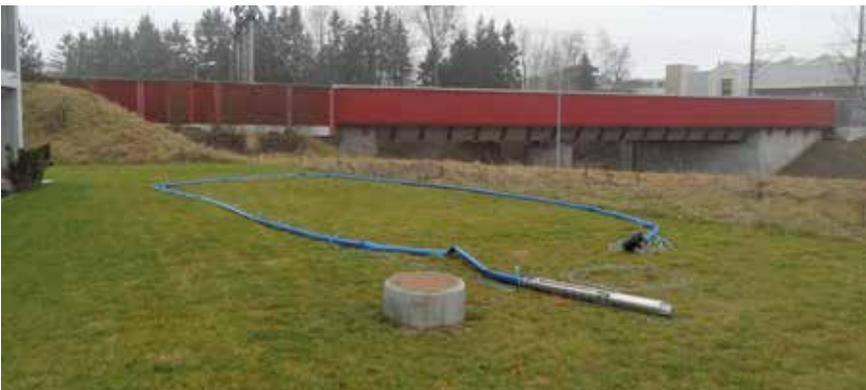
Ausgebaute Grundwasserpumpe: Mit Hilfe des langen Schlauchs wird das Grundwasser in die thermische Anlage gepumpt. (Bild: GWWP Staadacker II, Oensingen)
