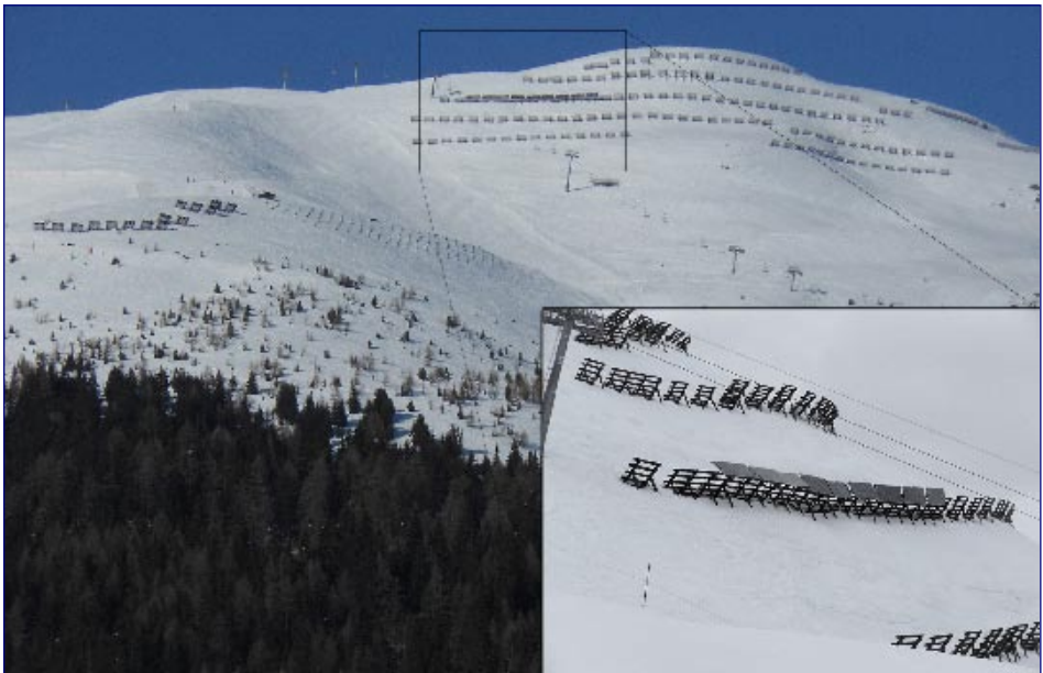
Abbildung 1. Die Lawinenverbauungen mit Photovoltaikanlagen von Bellwald aus gesehen. Links befinden sich einzeln montierte Panels, rechts zusammenhängend montierte (Fotos 4./7. 3. 2013).
