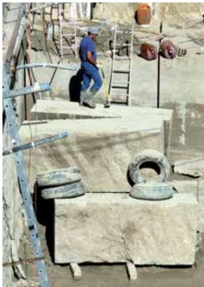
Un chantier à Genève: Extraction de blocs de molasse pour la rénovation de bâtiments historiques. (Photo: Michel Meyer)
