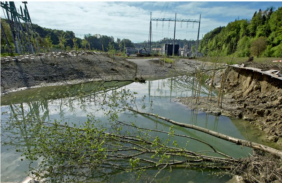
Abbildung 38: Ein Spezialfall bei der Unterstation Mühleberg ist die Nachbarschaft zur Aare und das entsprechende Aufwertungspotenzial. Deshalb wurde diese Restfläche zwischen den Abspanngerüsten als Altarm gestaltet. (Foto: Marco Zanoni)
