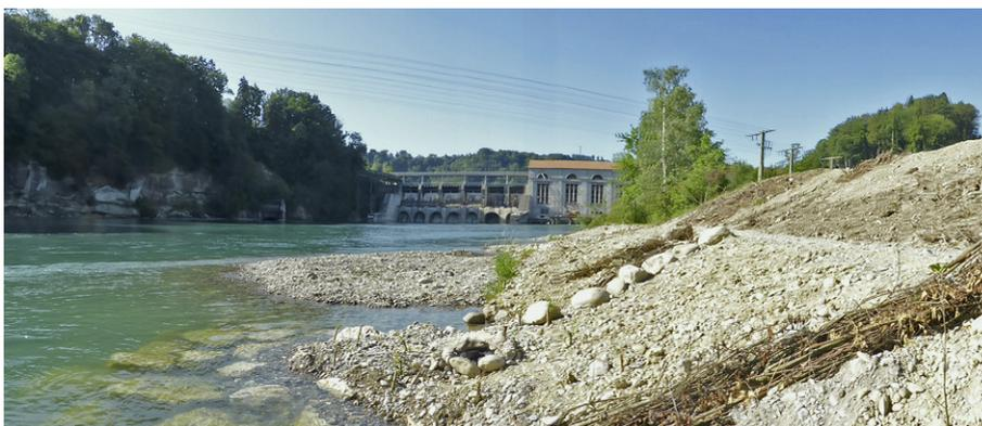
*Abbildung 40:* Das steile befestigte Ufer der Aare wurde nach dem Bau mit drei Stein-Buhnen und einer Kiesschüttung in eine Flachwasserzone umgestaltet. Während des Baus diente dieses Ufer als Ponton-Anlegestelle zur Verstärkung des Stauwehrs (hinten im Bild). (Foto: Heiko Zeh Weissmann)
