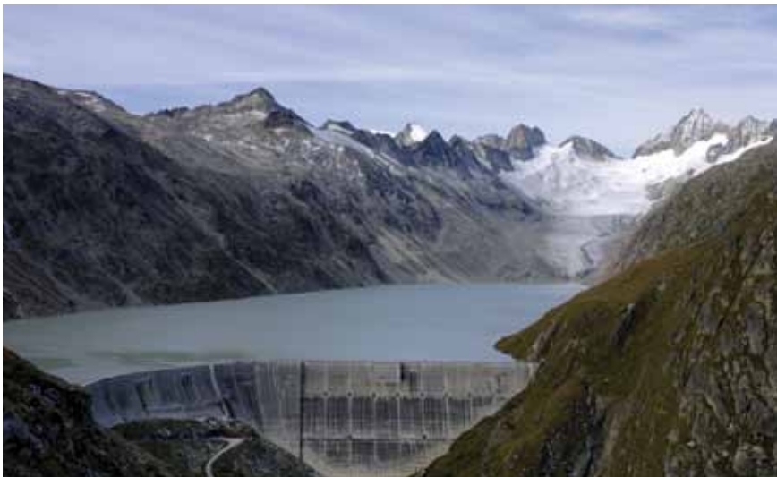
Der Oberaar-Stausee der Kraftwerke Oberhasli: Das Berner Kraftwerk muss in Zukunft mit vielfältigen Auswirkungen der Klimaänderung auf die Stromproduktion rechnen. (Bild: KWO)
