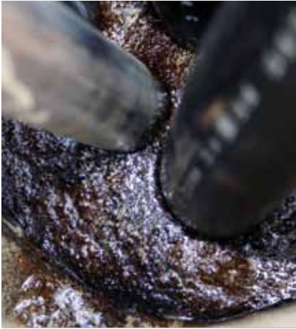
Einbau der ersten Erdwärmesonde: Ein leichtes Ausgasen von Erdgas ist bereits hier erkennbar. (Foto: Oliver Sachs)
