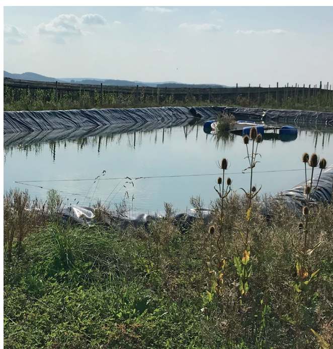
Folienteich als lokaler Wasserspeicher für eine Obstplantage. Bild: Adrian Auckenthaler, Pilotprojekt B.04
