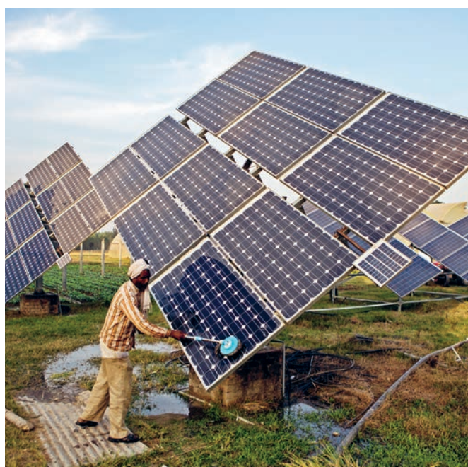
Abbildung 1: Ein Mitarbeiter eines landwirtschaftlichen Betriebs bei der Reinigung von Solarpaneelen betriebenen Grundwasserpumpe in Haryana, Indien. Foto: Prashanth Vishwanathan (IWMI)
