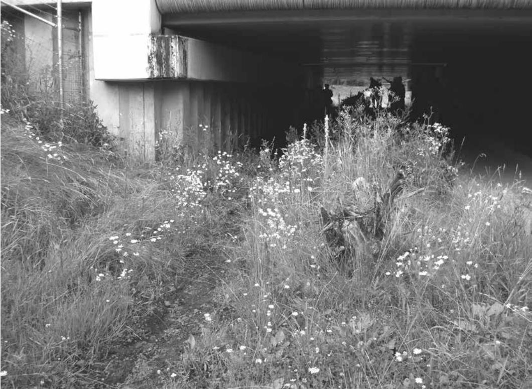
Wildtierpassagen bei Nistelrode in Holland: Mit Hilfe dieser Unterführung können Tiere die Strasse kreuzen, wodurch weniger Tiere getötet werden und die Barriere-Wirkung von Strassen vermindert wird. (Bild: Manuela Di Giulio)
