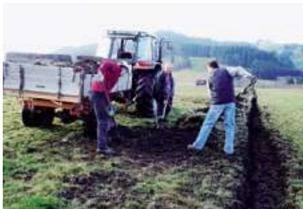
Abb. 15.4: Grabenunterhalt von Hand mit Abtransport des Grabenaushubs. Bei Handarbeit besteht geringere Gefahr, dass Riedgräben zu tief ausgehoben werden. Es fehlt noch die abschnittsweise Abschrägung der Grabenwand, damit Kleintiere und Jungvögel wieder herausklettern können.
