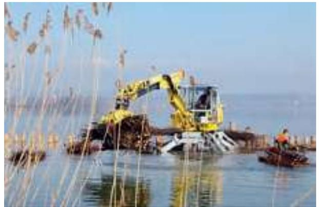
Abb. 14.8: Astbündel werden zwischen gerammte Holzstämmen verankert. Sie brechen die Wellenkraft und schützen dadurch das Ufer und das Schilf.
