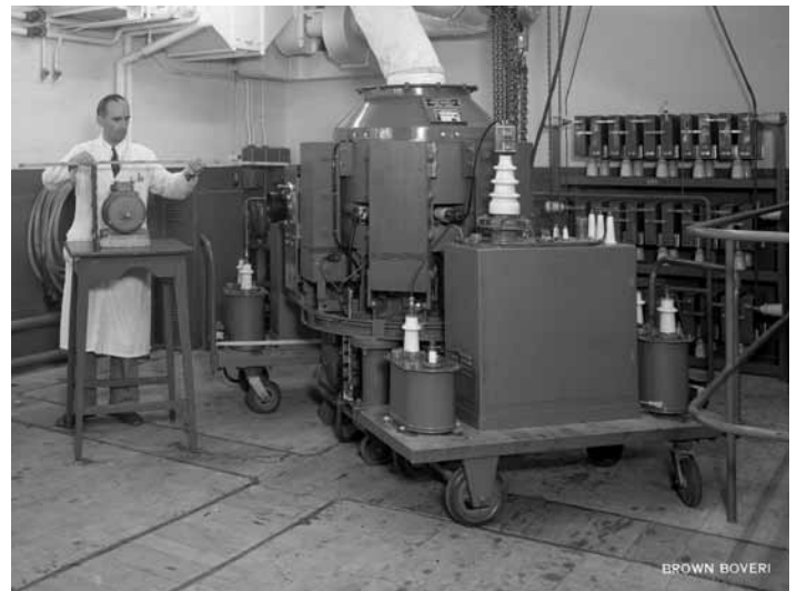
Fig 1: Im Strahlenlabor von Brown Boveri bereitet Rolf Wideröe die Durchleuchtung eines Elektromotors vor.
