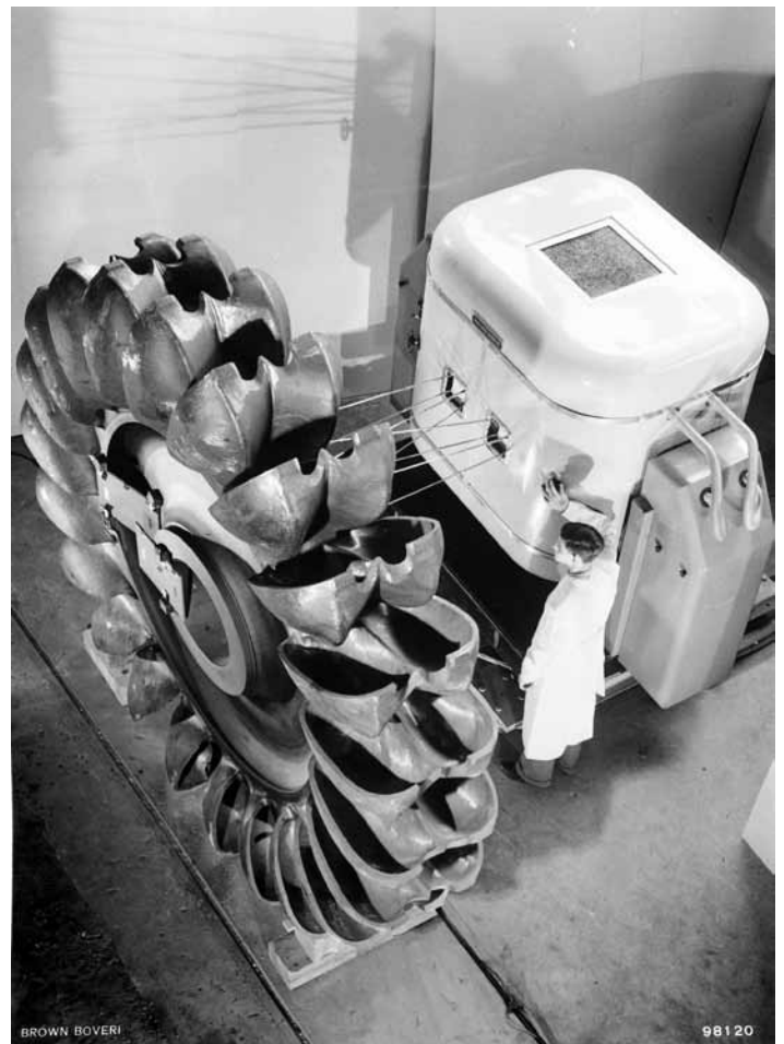
Fig 3: Zerstörungsfreie Prüfung einer Pelton turbine mittels Zweistrahlbetatron.
