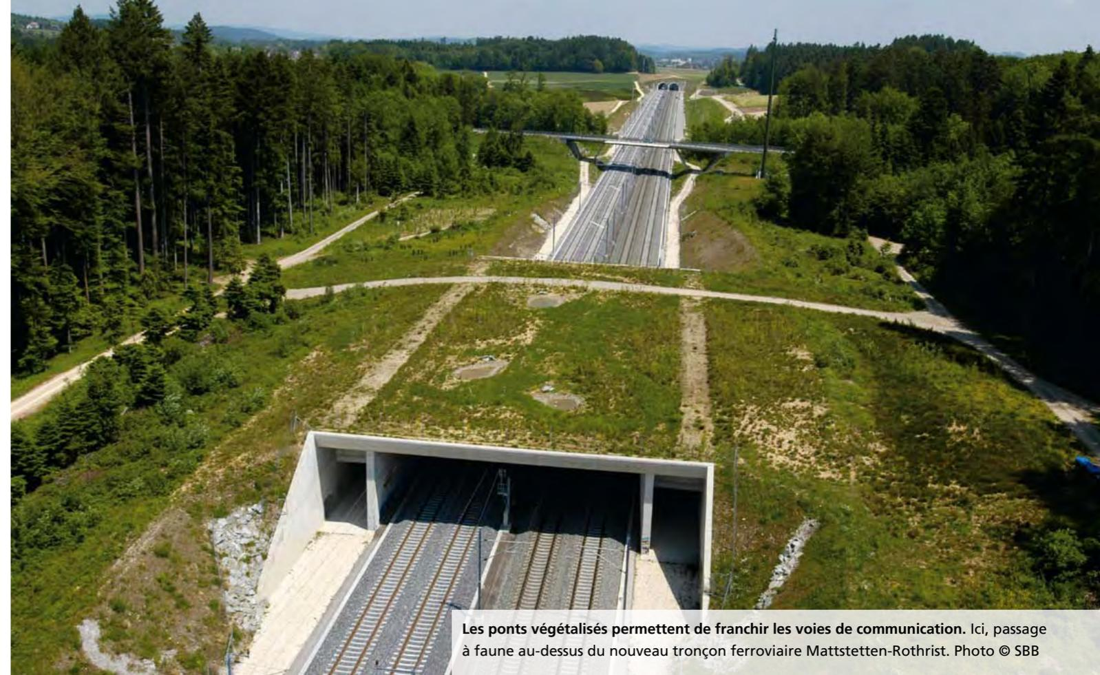
Les ponts végétalisés permettent de franchir les voies de communication. Ici, passage à faune au-dessus du nouveau tronçon ferroviaire Mattstetten-Rothrist. Photo © SBB
