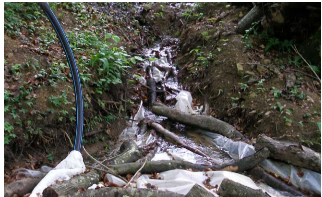
Abbildung 3.3 Geschädigter Quell-Lebensraum: Beispiel einer durch unbewilligte Ableitung von Wasser beeinträchtigten Quelle
