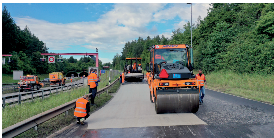
Praxistest von Strassenbelägen, die weniger Sonnenenergie absorbieren. Foto: BAFU .
