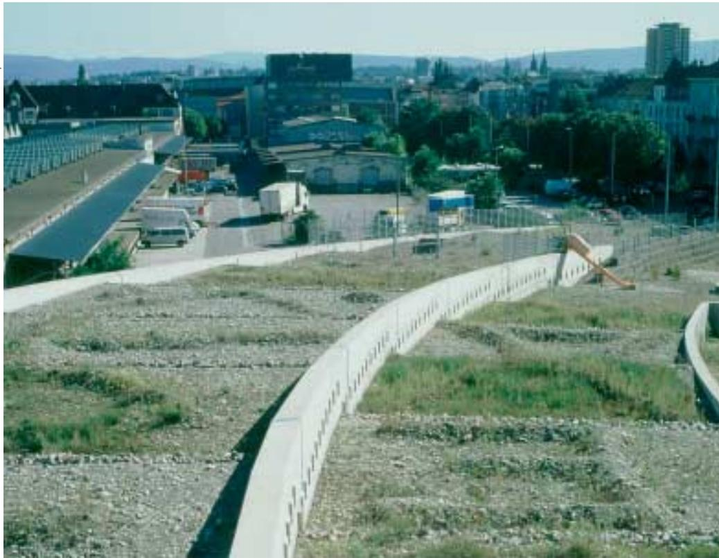
Auf der Überdachung der Autobahn in Basel wird die Funktionalität von reich strukturierten Dachbegrünungen mit verschiedenen Substratmischungen aus Wandkies und Oberbodenbestandteilen untersucht.
