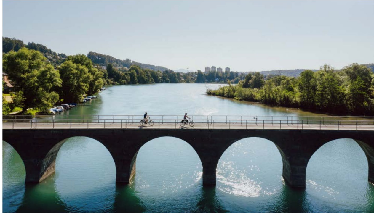
Stadt und Land verbinden wie am Wohlensee bei Bern – dafür braucht es ein gutes Team und die nötigen Mittel
