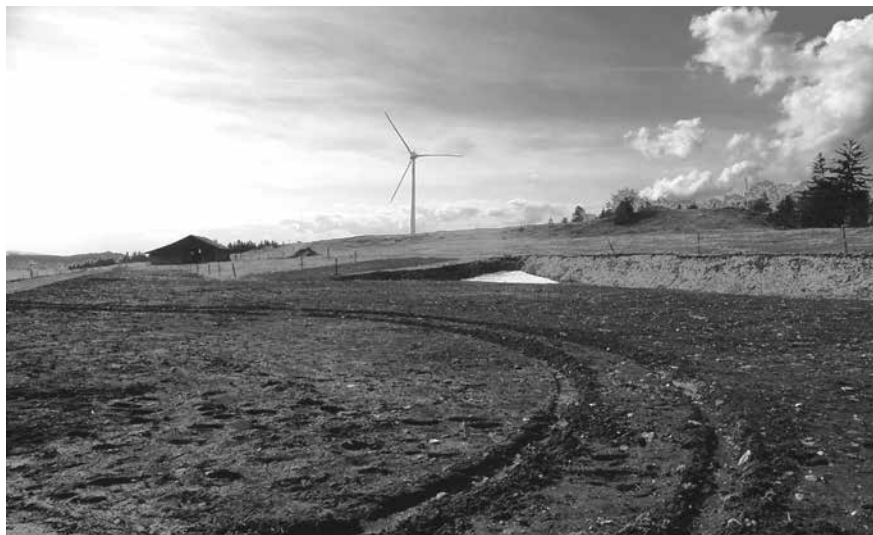
Windmühlen bei Saint Brais (JU): Der Bauplatz der zweiten Windmühle direkt nach dem Bau (im Vordergrund). Die Bodenschicht wurde grossflächig abgegraben und eingeebnet. Ob ein solcher Eingriff gerechtfertigt ist, muss von Fall zu Fall entschieden werden. | Eoliennes de Saint Brais (JU): Le chantier de construction des éoliennes juste après la fin des travaux. La couche de sol a été enlevée et nivelée sur une large étendue. De tels empiètements ne se justifient que cas par cas. (Foto | Photo: géo & environnement, Delémont)
