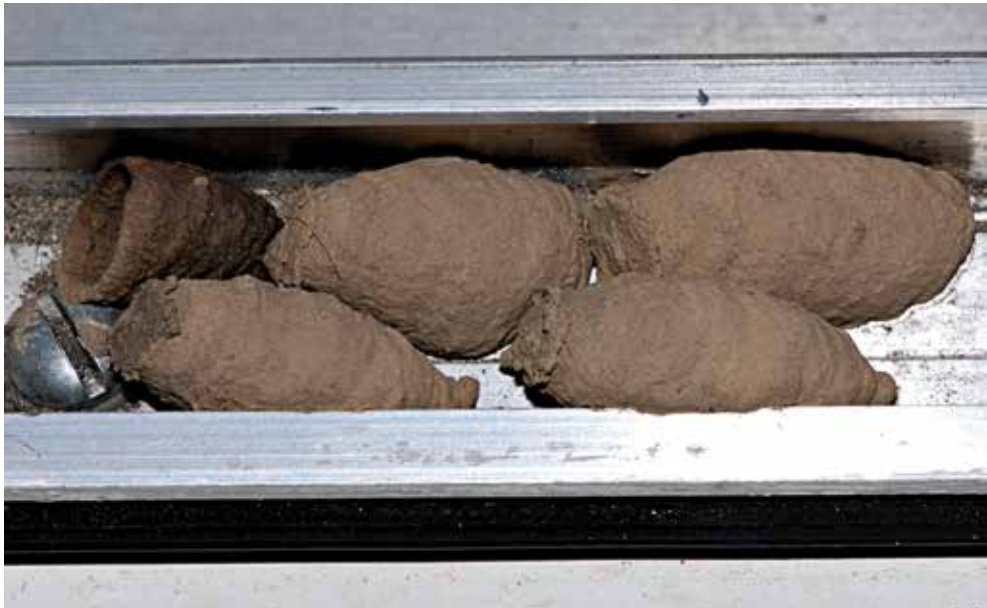
Abb. 2. Vier vollendete und eine begonnene Lehmzelle von S. curvatum im Fensterrahmen am Fundort Gümligen. (Foto R. Pflugshaupt)
