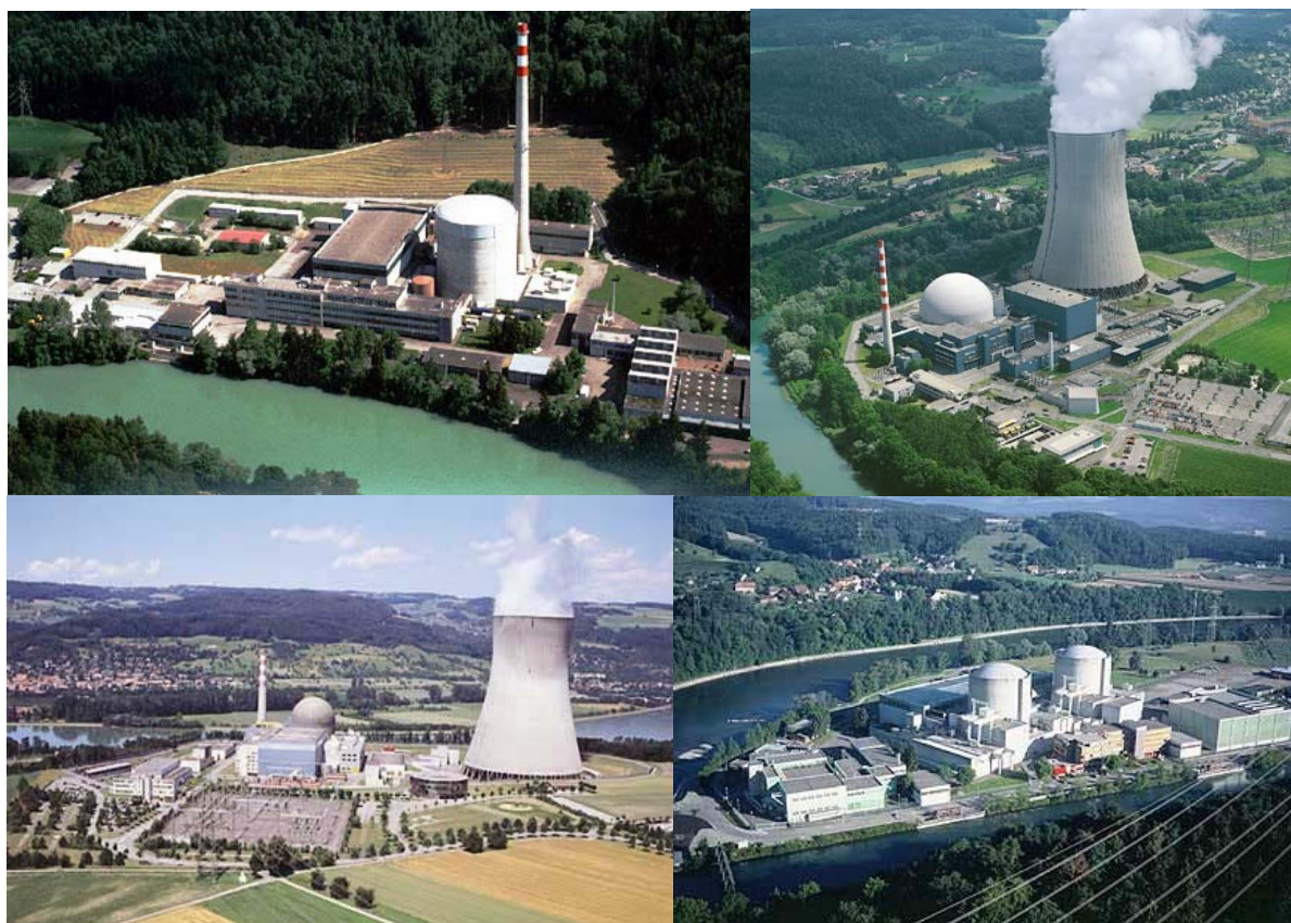
Fig. 11.1 Die Schweizer Kernkraftwerke Mühleberg, Gösgen, Leibstadt und Beznau
