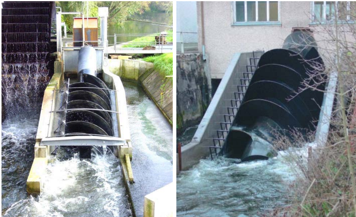
Fig. 4.4 Wasserkraftschnecken: 8.5 kW und 65 kW. d
