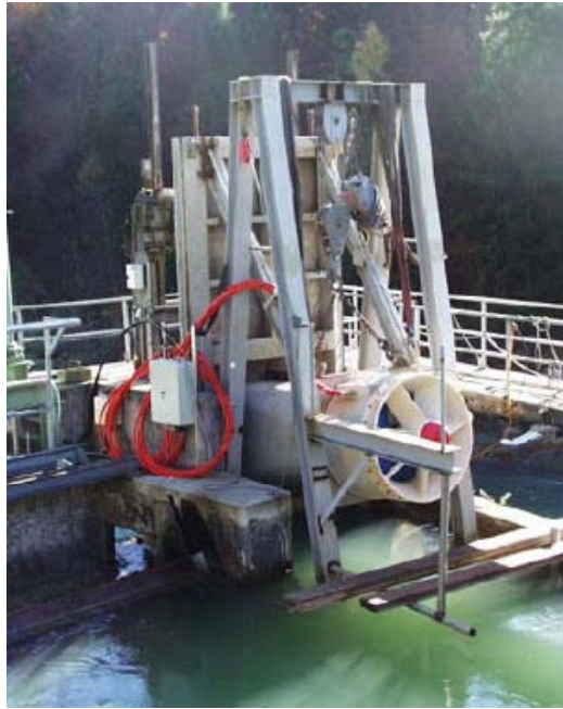
Fig. 4.5 HYDROMATRIX Testanlage im oberösterreichischen Kleinwasserkraftwerk Agonitz (Bihlmayer & Koleber 2004).
