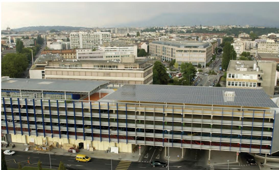
Abbildung 3: Eine auf der Grossgarage P+R de l'Étoile in Genf installierte Photovoltaikanlage. Fotoautor: Services industriels de Genève, SIG.
