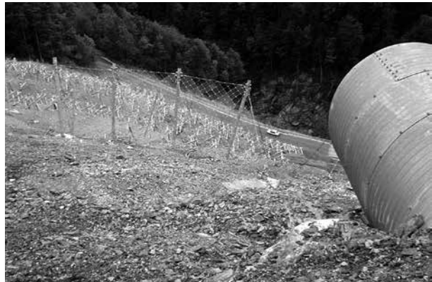
Eindrücklich: Der gesicherte Hang des Cholrütirutsches im Melchtal (OW) zwei Jahre nach dem Unwetter im August 2005. (Bild: Martin Trüssel)
