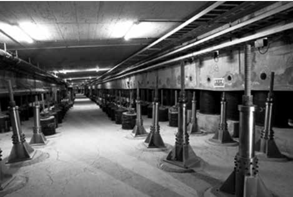
Knautschelemente unter dem Tunnel: Bautechnische Massnahmen verhindern die Deformation der Fahrbahn. (Bild: Aegerter & Bossart AG)
