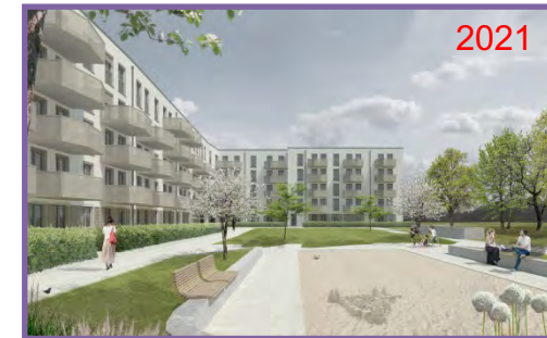
SWM Werkwohnungen u. KiTa Postillonstr. 3, © Laux Architekten
