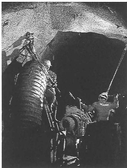
*Ein Bohrkern wird aus einem aufwärtsgerichteten Bohrloch gezogen. Beim Bohren mit Hochdruck entsteht viel Staub, dieser wird mit einem Lüftungsrohr von 60cm Durchmesser abgesogen.*
