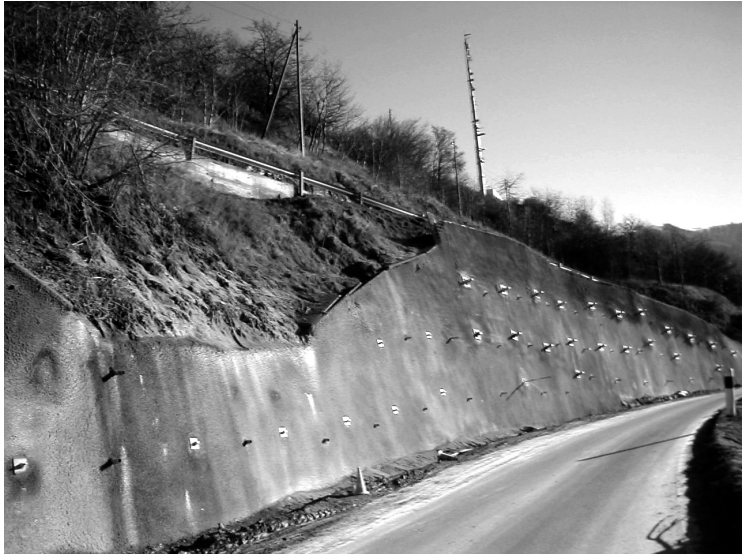
Abb. 2: «Klassische» ingenieurgeologische Beratungs- tätigkeit am Beispiel einer Böschungssicherung in Vey- sonnaz (VS). Sicherung durch Mikrobohrpfähle, Vor- spannanker und Spritzbeton sowie die Kontrolle von Böschungsdeformationen durch Inklinometer.
