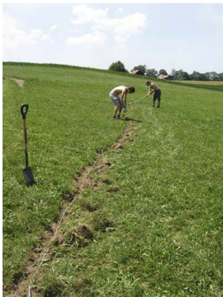
Lors de l'installation du réseau sismique, des câbles ont été enterrés comme ici à Flamatt. (Photo: Naomi Vouillamoz)
